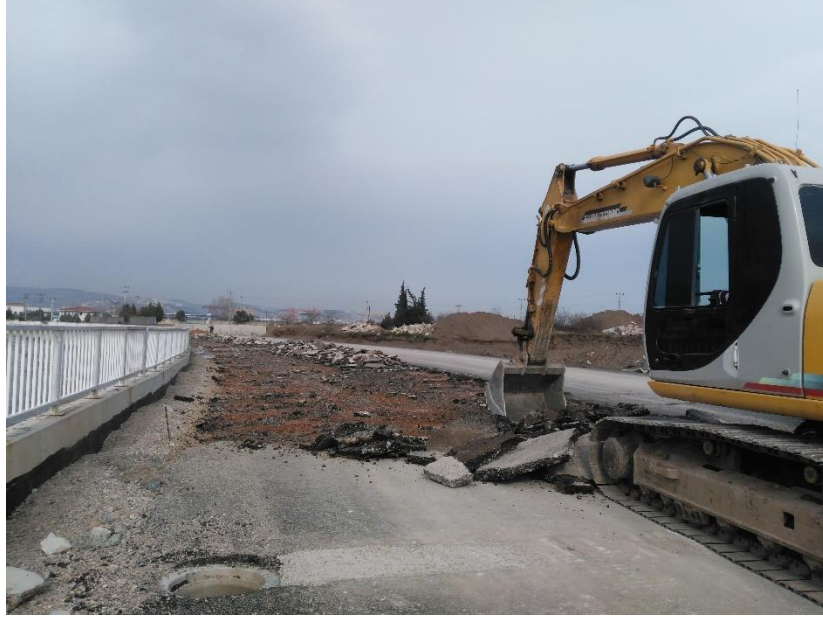
Şekil 2. Bitümlü Temel tabakasının sökülmesi
