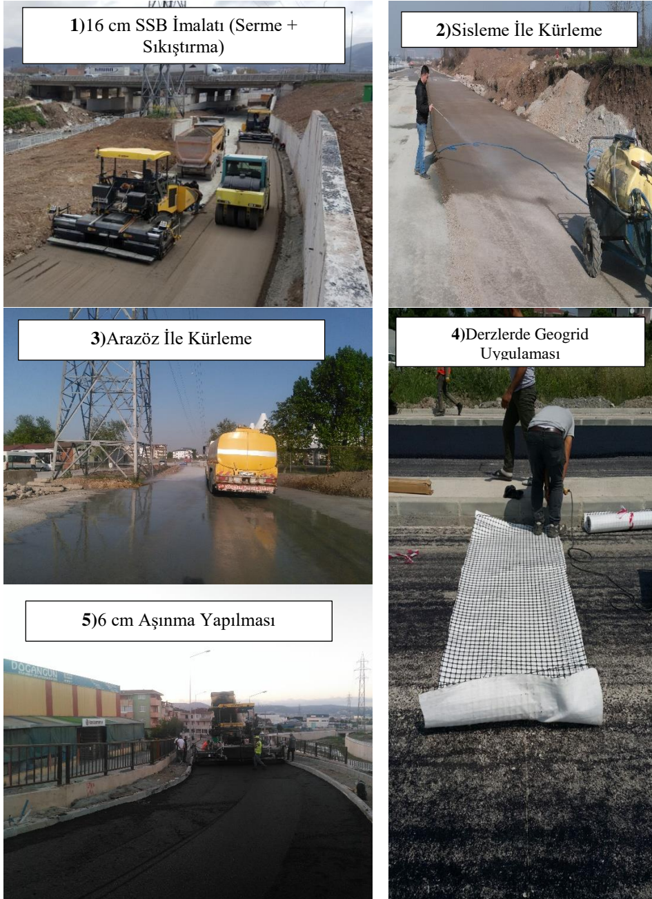
Şekil 5. Kompozit yapı imalatına ait görseller
