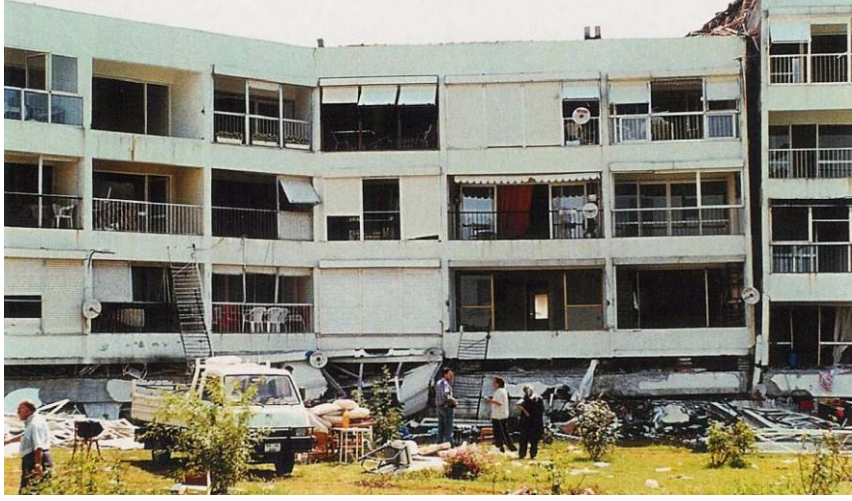
Şekil 6: Yalova Çiftlikköy Aydın sitesindeki bloklarda 17 ağustos 1999 depremi hasarı
