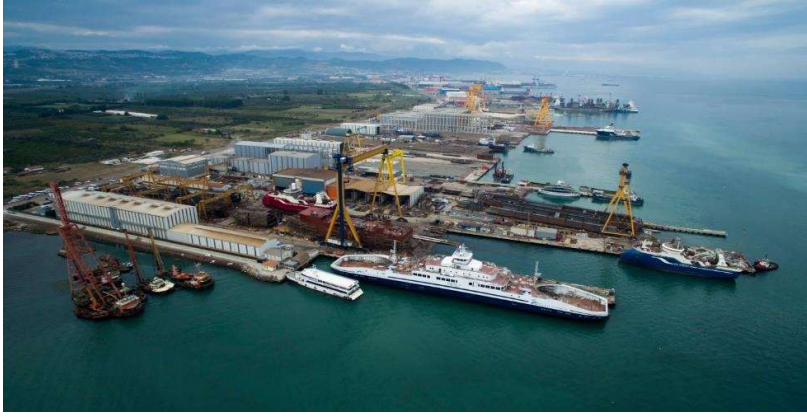
Şekil 1: Yalova Tersaneler Bölgesi Genel Görünüş
