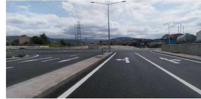
Şekil 7. Kaplamanın bitmiş hali (2017)
